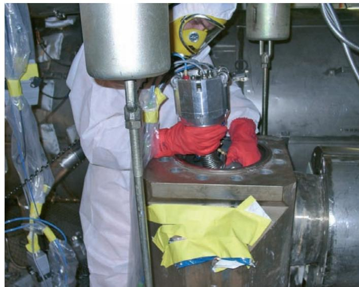
nur sehr wenig Raum zur Verfügung stand. So war es eine Notwendigkeit, den Inspektionsroboter durch eine geöffnete Armatur in die Rohrleitung einzusetzen und ihn ferngesteuert durch einen Bogen zu der Prüfkomponente zu fahren.
